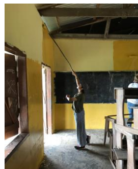
小学校の改修工事の手伝い
