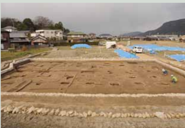
大型掘立柱建物跡 南から
