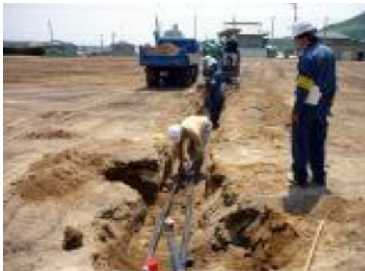
●スプリンクラーの配管工事の様子です。
