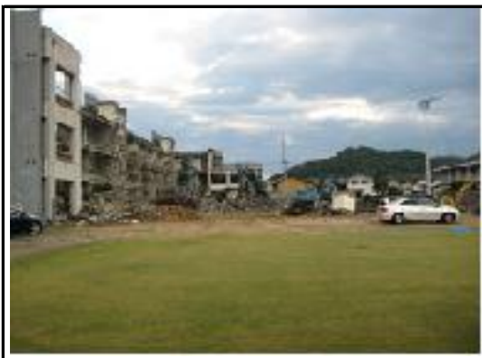
● 現況(解体工事中)(平成22年8月)
