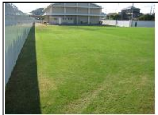
● 現況(解体工事中)(平成22年8月)
