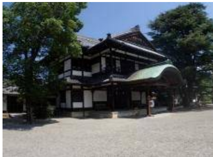
商工奨励館（本館）
