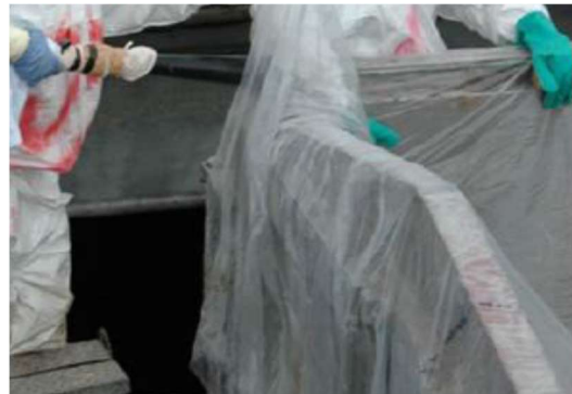
ブルーシートで覆い炭酸ガスを注入
