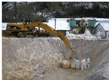
埋却溝の掘削
