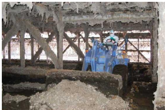
重機による除去作業
