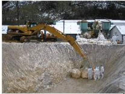
埋却溝の掘削
