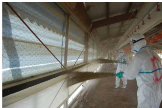
ほうきを用いた鶏舎側面の清掃
