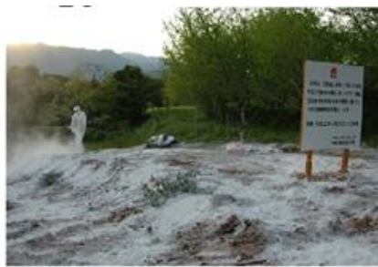
埋め戻した後、消石灰を散布し、立て看板を設置
