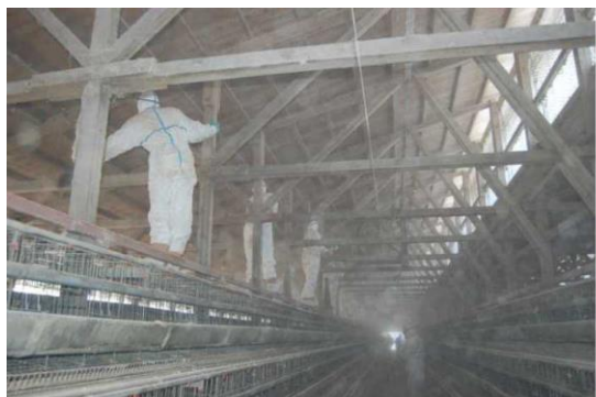
ケージに登って柱や梁のすす払い
