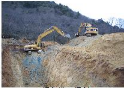
埋却溝の掘削
