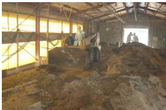
重機による除去作業
