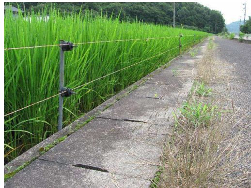
イ 柵の外がコンクリートのためアースが不十分で通電性に欠ける電気柵
