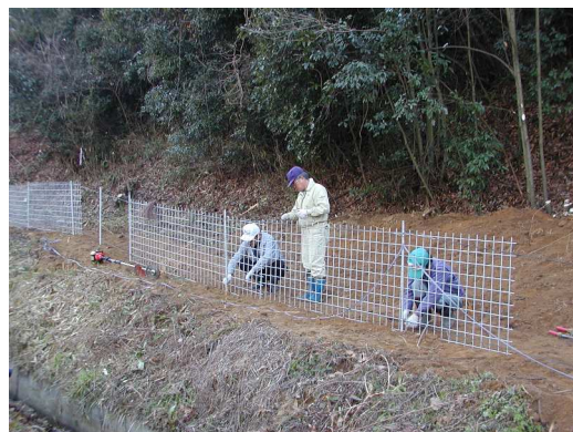
エ 集落ぐるみで設置する侵入防止柵
