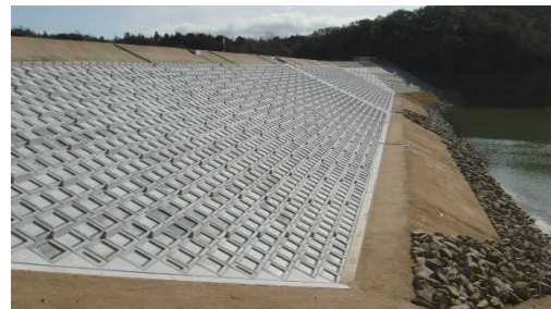
▲工事で発生した石材を法面保護材に再利用
