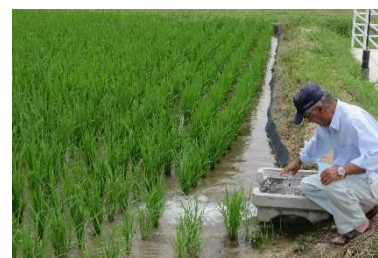
▲パイプラインによる給水
