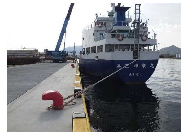
東運河岸壁増深部供用開始 (H30) -5.5m岸壁 L=100m
