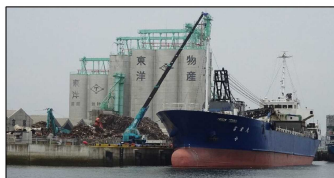
<西ふ頭地区における金属くず荷役の様子>
