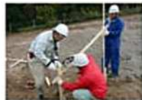
丁張りの設置
