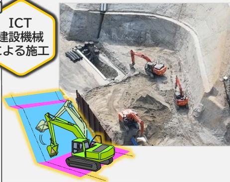
**3次元設計データを導入したICT建設機械**(マシンコントロール技術、マシンガイダンス技術)により操縦者の機械操作の補助します。施工位置の確認ができることにより、**丁張の設置や施工補助者の配置、施工中の検測を省略**することができます。マシンコントロール技術:建機の位置情報と設計データを活用し、建機を半自動制御するシステム
