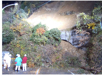
■平成16年大雨による法面崩壊（三豊市財田町）
