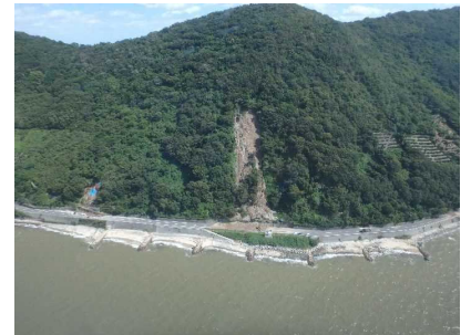
■平成30年台風24号による土砂崩壊（坂出市大屋富町）
