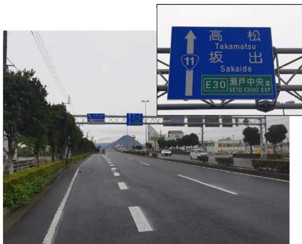
国道11号 香川県丸亀市
