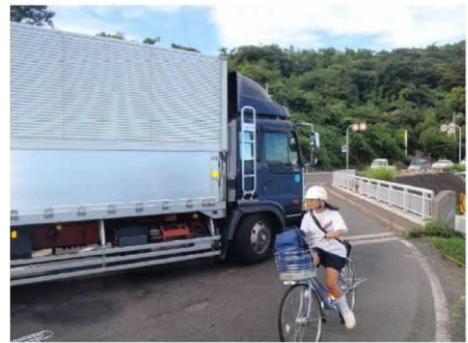
【白方跨線橋の状況（さぬき浜街道）】
