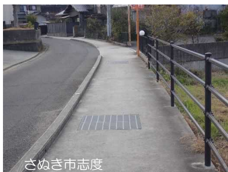
側溝の暗渠化（コンクリート蓋）
