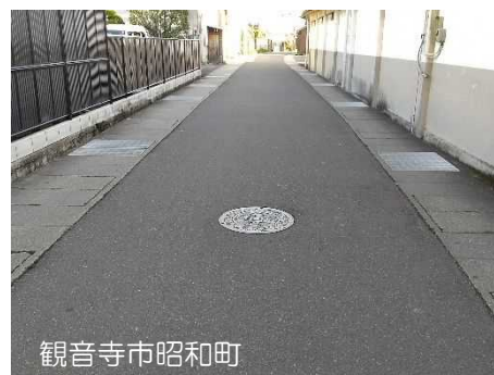
側溝・水路の暗渠化（コンクリート蓋）
