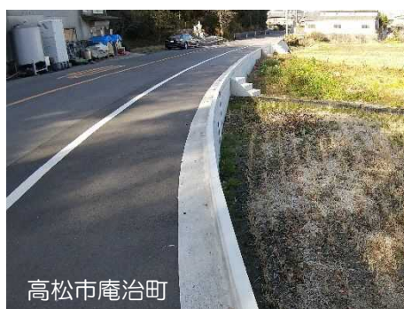
道路端部の改修
