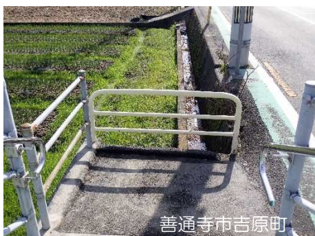
車止め柵を用いた対策
