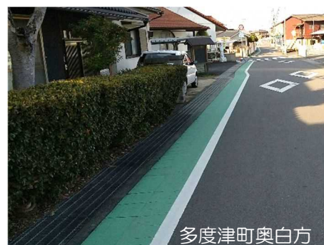
側溝・水路の暗渠化（コンクリート蓋）
