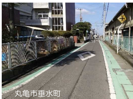
側溝・水路の暗渠化（コンクリート蓋）
