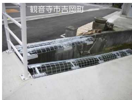
転落防止カバーの設置
