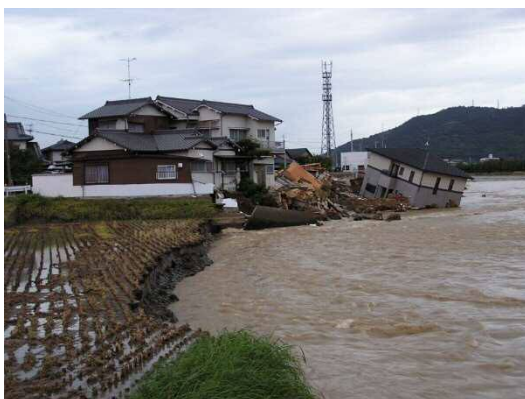
写真2－平成16年被災状況
