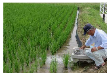
▲パイプラインによる給水
