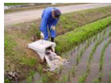
▲パイプラインによる給水
