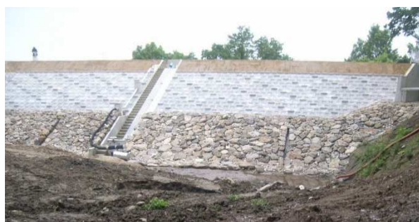
▲工事で発生した石材を法面保護材に再利用
