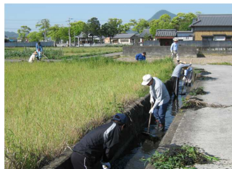
▲水路の泥上げ
