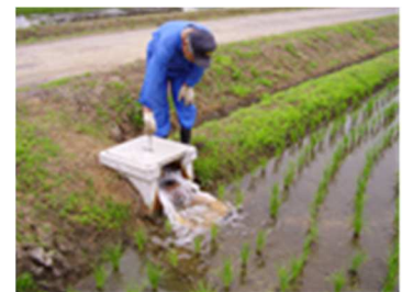
▲パイプラインによる給水
