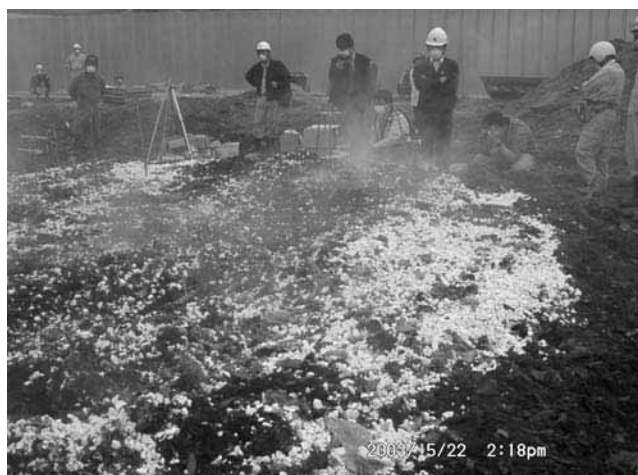
SDに生石灰添加実証試験(そのまま放置)11分後
