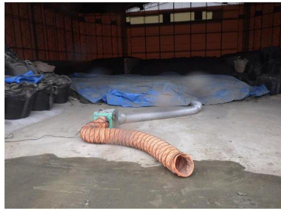
写真10 ガス吸引処理の状況
