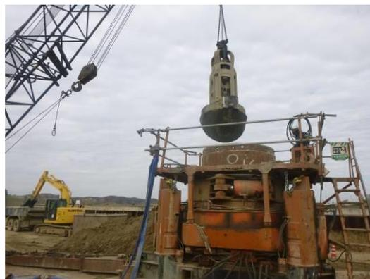
写真4 ハンマグラブによる掘削状況
