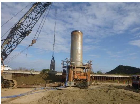
写真3 ケーシング管の建込状況
