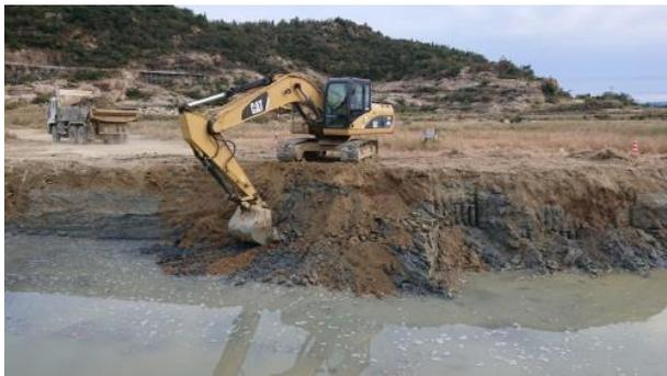
写真1 浸透池の掘削状況 (R3. 10. 21)
