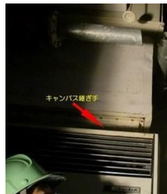
（参考資料）写真 6－11 キャンバス継ぎ手
