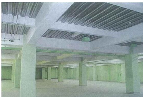
(参考資料) 写真 6-12 けい酸カルシウム板第 2 種を耐火被覆として使用している例 (この施工例は石綿含有なし製品)
