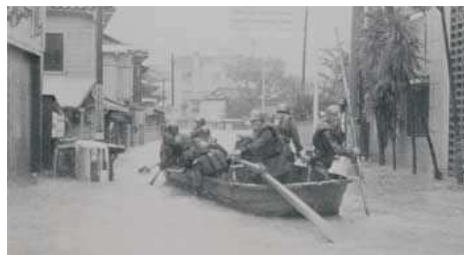
図1-8 小豆島町の浸水被害状況
