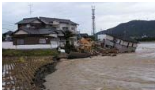
図1-10 高松市の被災状況
