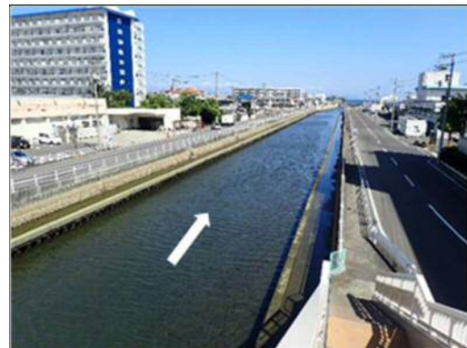
新摺鉢谷川橋下流
