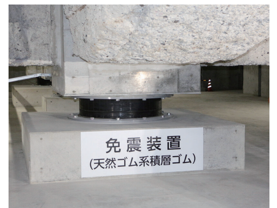
東館を支える免震装置
