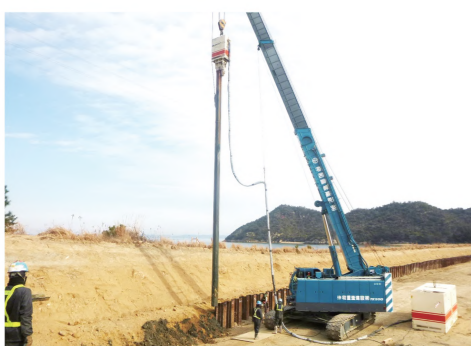
遮水壁の引抜き工事の様子
