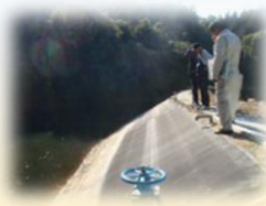
遮水シート設置
