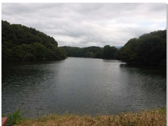
堤頂より上流を望む
