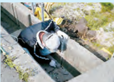
水路の目地詰め
