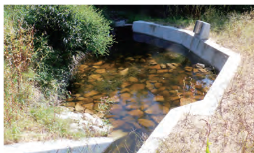
発生石を流用した水生生物の生息域の整備
