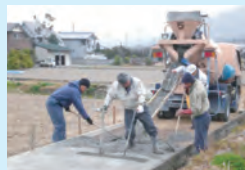
農道の舗装(長寿命化)
