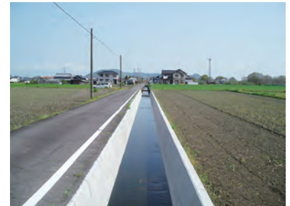
〔改修後〕 水利施設整備事業 (基幹水利施設保全型)
