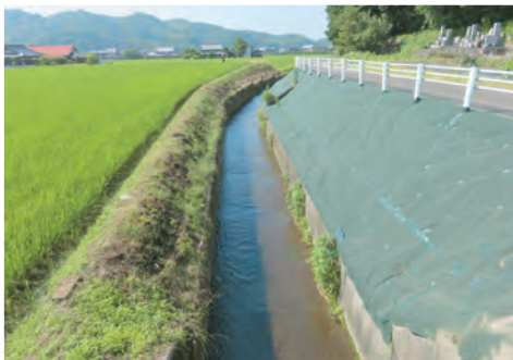
防草シート施工後（まんのう町）
