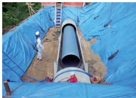
[鋼管据付状況]
