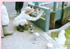
ゲート類の保守管理
