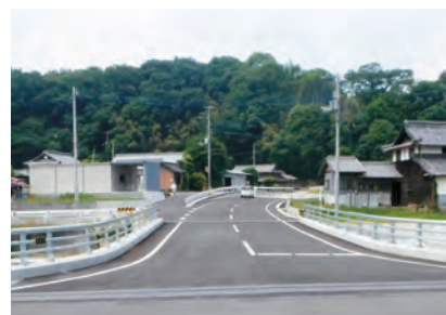
広域営農団地農道整備事業 西讃南部地区(観音寺市・三豊市)
