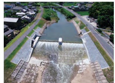
農業用河川工作物応急対策事業 野間池堰(さぬき市)
