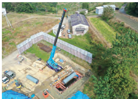
[鋼管吊込状況]
