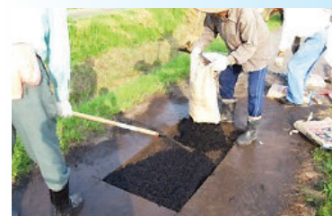
農道の部分補修
