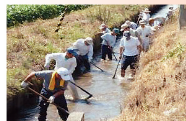
水路の泥上げ
