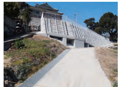
地すべり対策事業 馬越地区(土庄町)
