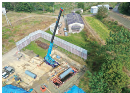
〔鋼管吊込状況〕
