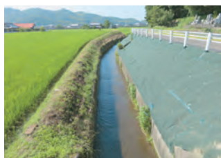
防草シート施工後(まんのう町)
