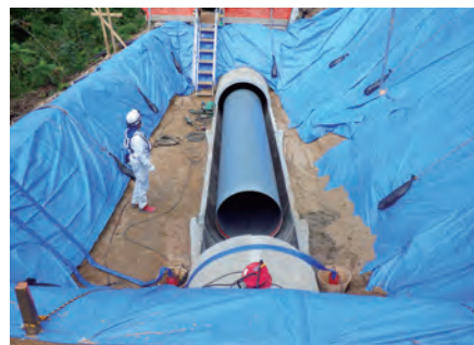
〔鋼管据付状況〕
