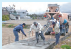
農道の舗装(長寿命化)
