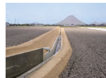
用排水路の整備や 畦畔復旧により 湛水機能の回復
