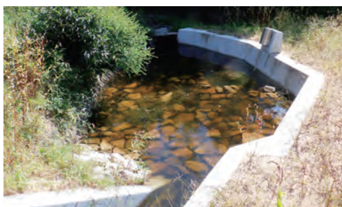
発石を流用した水生生物の生息域の整備
