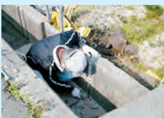
水路の目地詰め
