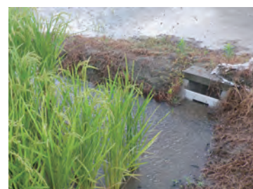
専用せき板設置状況
