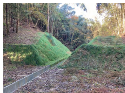
防災上放置できないため池の貯水機能廃止 上：対策前、下：対策後
