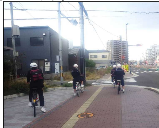
整備後(一部車道工事中)
