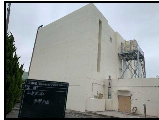
第1ポンプ場建設工事(完成)
