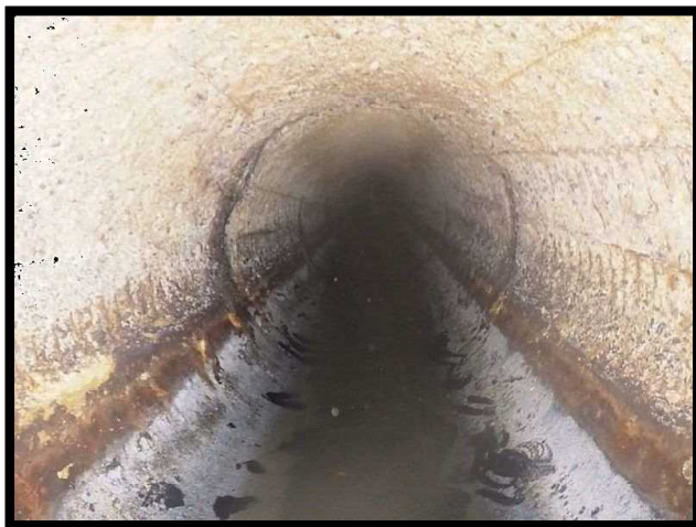
管更生(既設管)改築工事(着工前)
