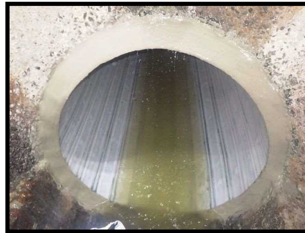
管更生(既設管)改築工事(着工前)
