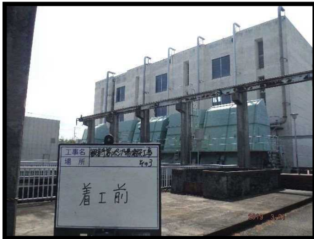
第1ポンプ場建設工事(着工前)
