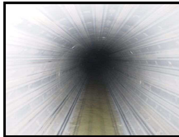
管更生(既設管)改築工事(完成)
