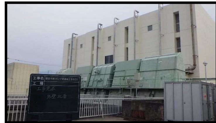
第1ポンプ場建設工事(完成)
