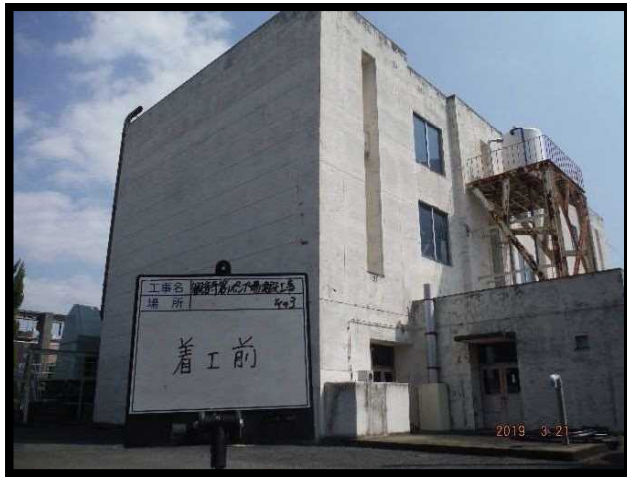
第1ポンプ場建設工事(着工前)
