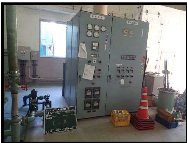
第1ポンプ場電気設備工事(着工前)
