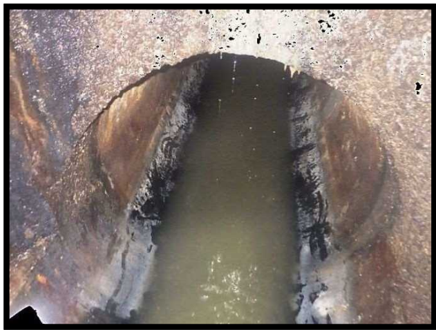
管更生(既設管)改築工事(着工前)
