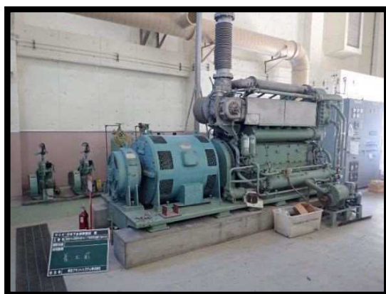
第1ポンプ場電気設備工事(着工前)
