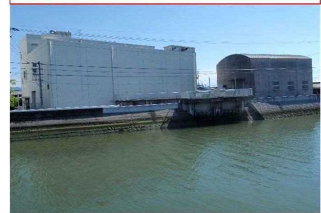
第2ポンプ場 ↓ 南部ポンプ場 ↓
