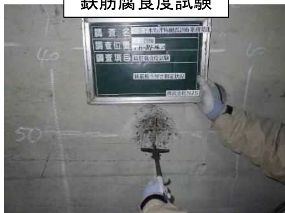
鉄筋腐食度試験
