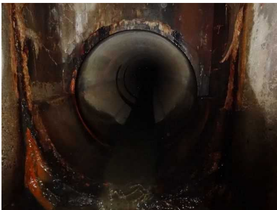
管渠マンホール接続状況
