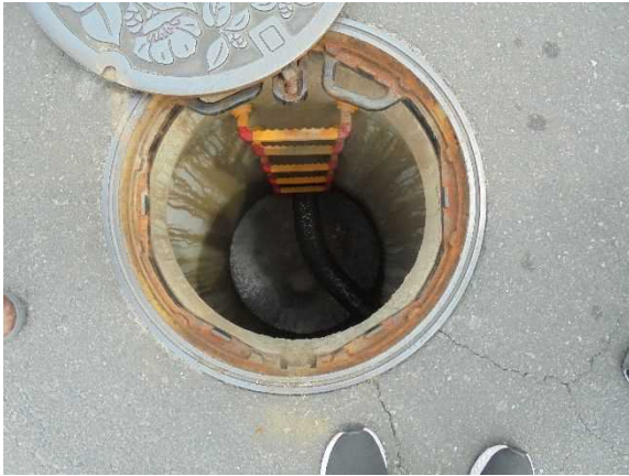
マンホール状況
