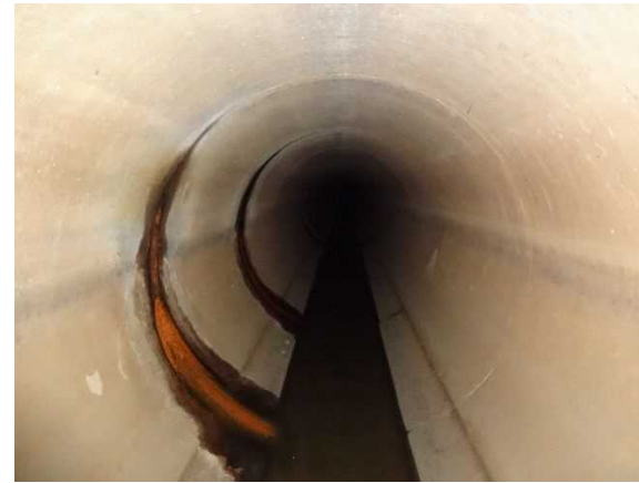
鉄筋コンクリート管内状況
