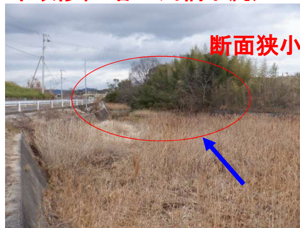
未改修(上春日川橋下流)
