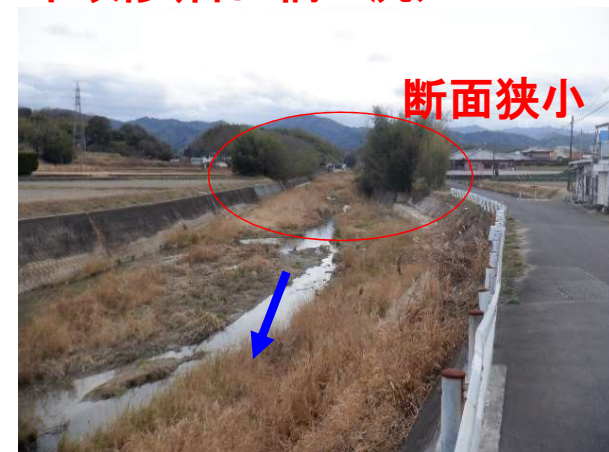
未改修(稗田橋上流)
