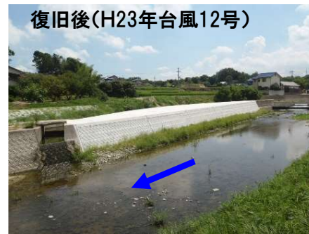
荒井頭首工下流
