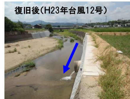
上春日川橋下流
