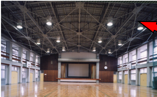
【屋根面フリース補強の例】 ・体育館
