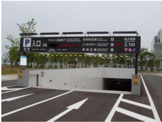
多目的広場地下駐車場 (H16.3)
