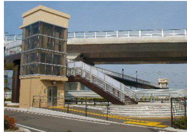
檀紙歩道橋昇降機棟 (H15.12)
