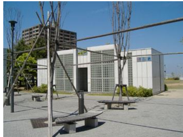
多目的広場公衆便所 (H16.3)
