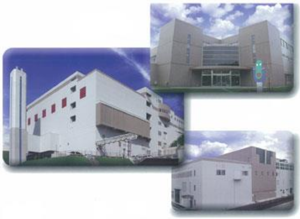
南部広域クリーンセンター (H16.3)
