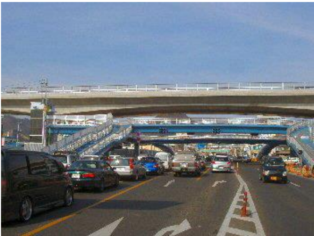
上天神歩道橋昇降機棟 (H15.12)
