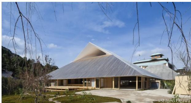
直島ホール (直島町民会館体育館棟) (H27.12)
