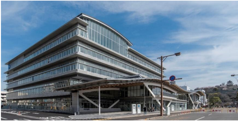
丸亀市市庁舎・市民交流活動センター (R3.4)
