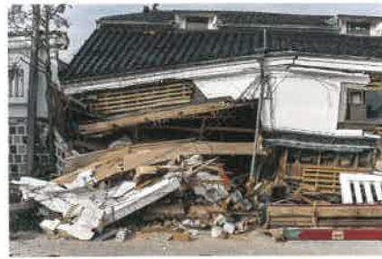
地震による被害例 (能登半島地震)
