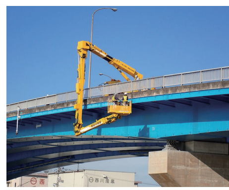
▲橋梁点検 (県道大屋築港宇多津線(両景橋))
