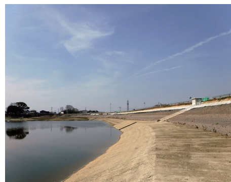
▲ため池の耐震補強工事
