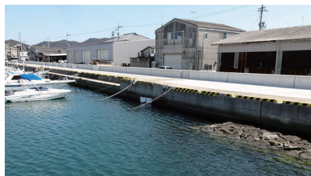
▲地震・津波対策工事(志度港)
