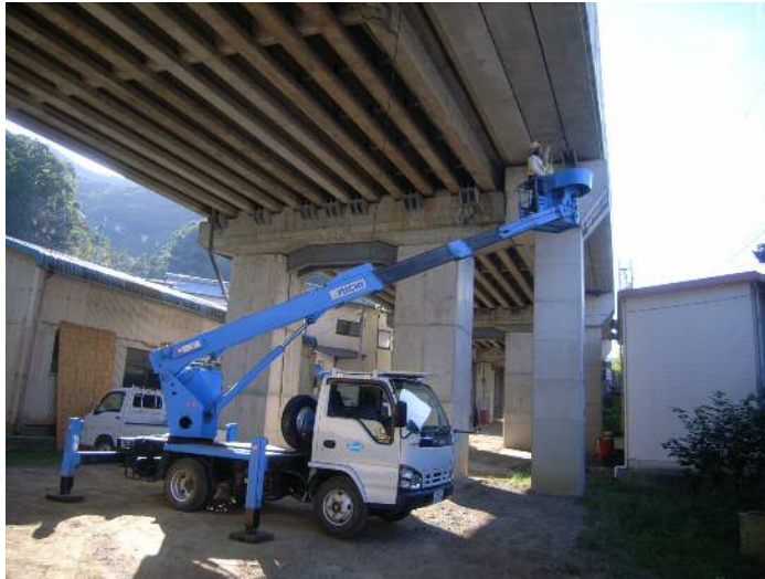
写真-5.1 高所作業車による点検の例
