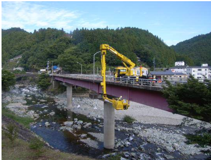
写真-5.1 高所作業車による点検の例
