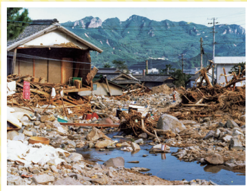
土砂災害によって被害を受けた小豆島の神懸通の様子。
