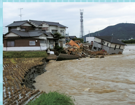
平成16年の台風23号により被害を 受けた本津川の様子。
