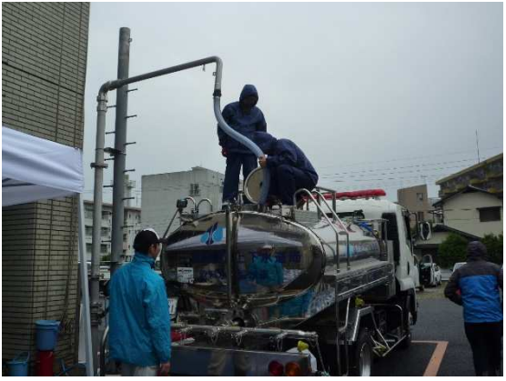
給水車への給水活動の様子 (熊本県熊本市)
