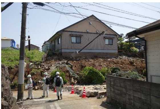
被災建築物応急危険度判定活動の様子（熊本県益城町）
