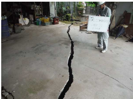
被災宅地危険度判定活動の様子（熊本県益城町）
