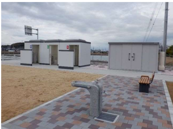
防災トイレ・防災倉庫
