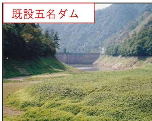
H6. 8 既設五名ダム枯渇状況
